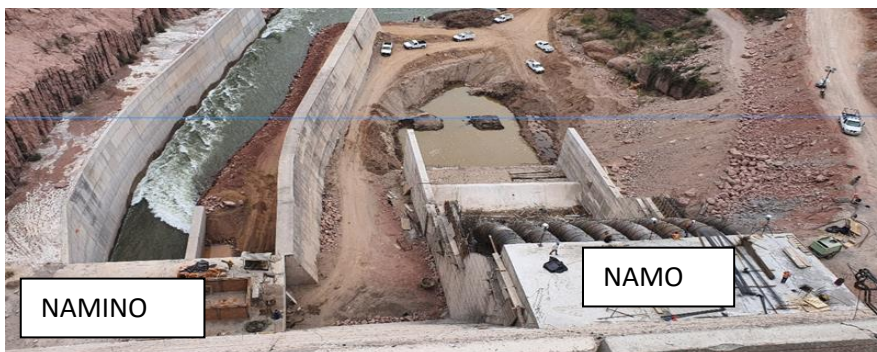
Ilustración 1 Fotografía que muestra la válvula de fondo (NAMINO) y los 8 tubos de descarga rápida en el (NAMO)
